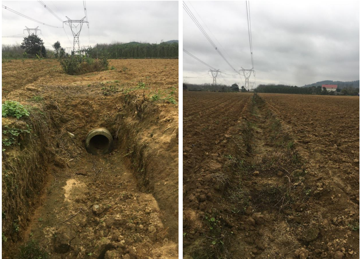
Hình 3: Mương đất thoát nước khu vực
